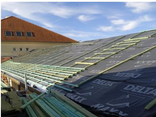
3 Tetőszerkezet építés közben
